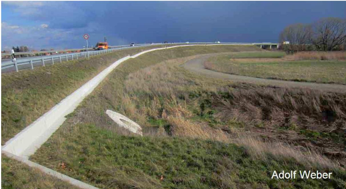
Diese neu entstandene B96-Umfahrung, Massener Landstraße genannt, erhielt eine Regenwasserentwässerung. Es entstanden X Regenwasserklärbecken, deren Überläufe in den Ponnisdorfer Graben münden. Zusammen mit einer Ausgleichsmaßnahme direkt neben der Kleingartenanlage gibt es nun erweiterte Angebote für Teichfrosch, Laubfrosch, Teichmolch, Kammolch und Ringelnatter. Vielleicht auch wieder für die einst hier gehörte Kreuzkröte.
